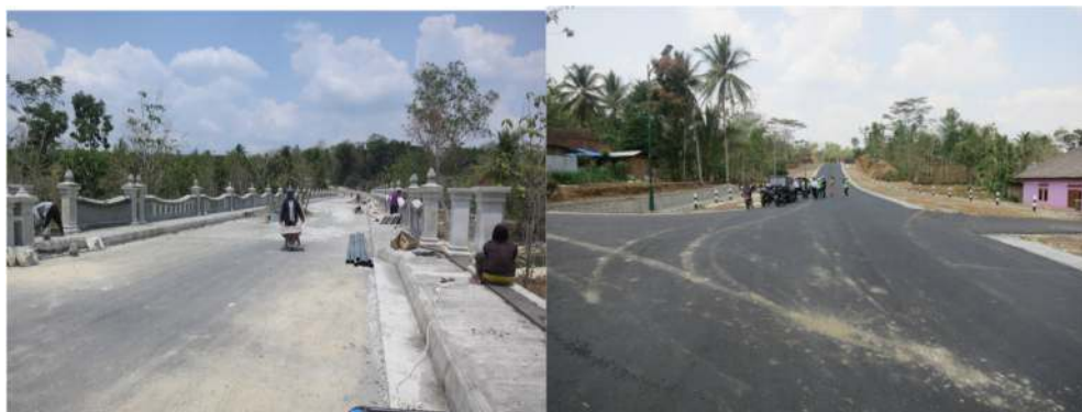
Gambar 2-33 Pembangunan Jalan/Jembatan Ngalang-Nguwot-Gading, Kab. Gunungkidul
