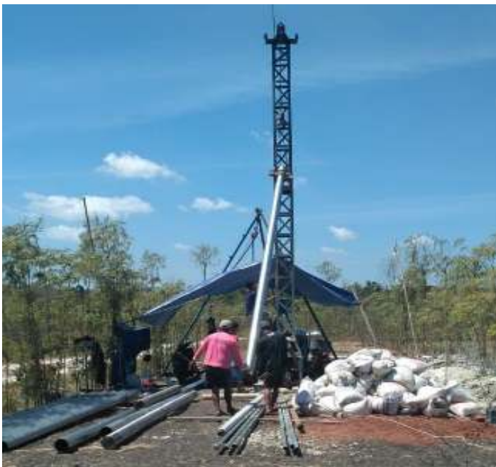
Gambar 2-69 Pembangunan sumur bor air tanah dalam di daerah sulit air di Kabupaten Gunungkidul
