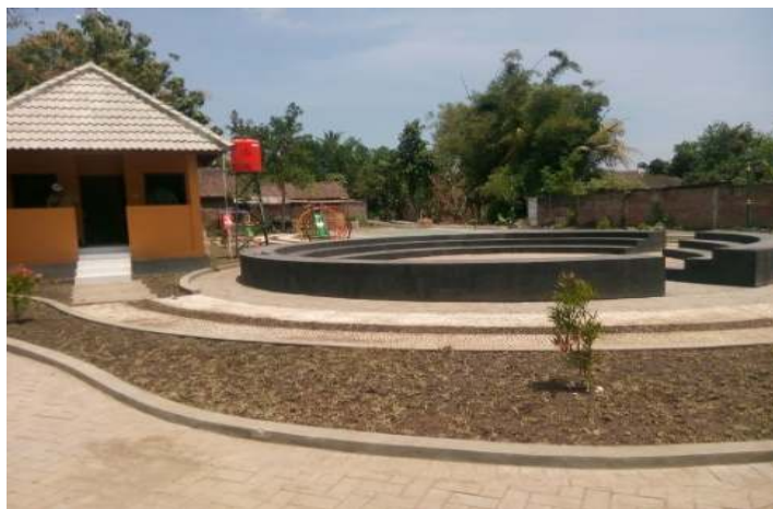
Gambar 2-34 Peningkatan kualitas prasarana sarana dan utilitas (PSU) di Kecamatan Sewon Kabupaten Bantul
