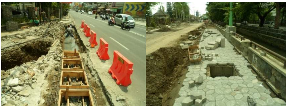
Gambar 2-32 Pembangunan Saluran Drainase di Jalan Kaliurang Simpang MM UGM Kabupaten Sleman
