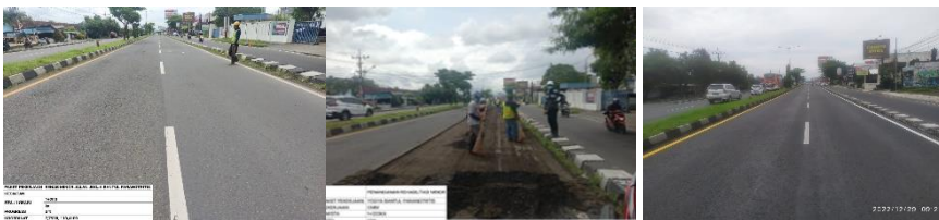
Gambar 4.7. Pelaksanaan Pekerjaan Rehabilitasi Minor Ruas Jalan Arteri Selatan (Yogyakarta) Sumber: Dinas PUPESDM DIY, 2023
