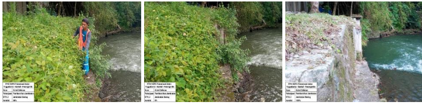
Gambar 4.5. Pelaksanaan Pekerjaan Jembatan Bedog Sumber: Dinas PUPESDM DIY, 2023
