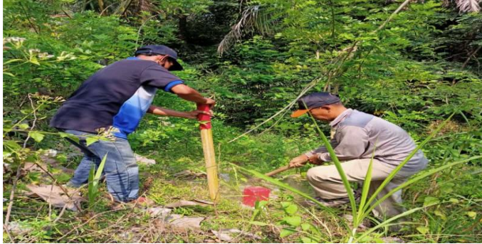
Gambar 5.15. Kegiatan BKK Pertanahan (Pemasangan Patok Batas Bidang) Sumber: Paniradya Kaistimewan DIY, 2023
