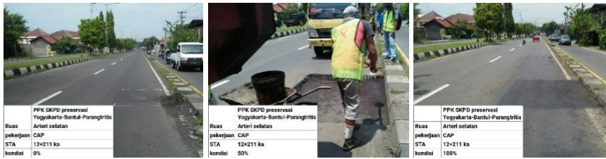
Gambar 4.6. Pelaksanaan Pekerjaan Ruas Arteri Selatan (Yogyakarta) Sumber: Dinas PUPESDM DIY, 2023
