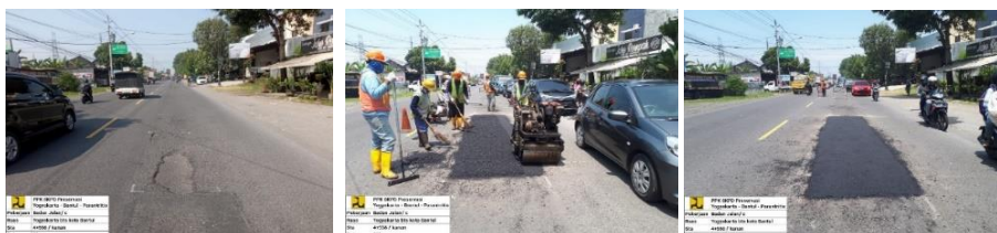
Gambar 4.4. Pelaksanaan Pekerjaan Ruas Yogyakarta-Bts Kota Bantul
