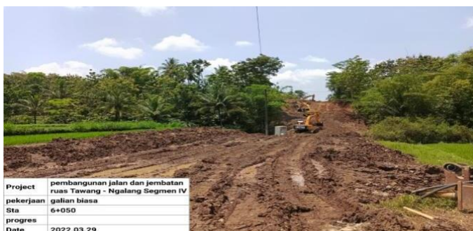
Gambar 5.16. Pembangunan Ruas Jalan dan Jembatan Tawang - Ngalang Segmen IV: 3,4 km
