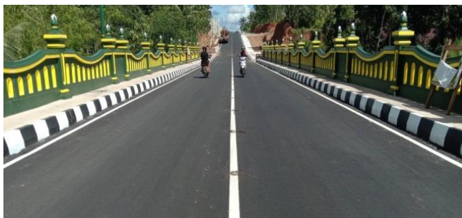
Gambar 5.17. Pembangunan Ruas Jalan dan Jembatan Tawang - Ngalang Segmen IV: 3,4 km
