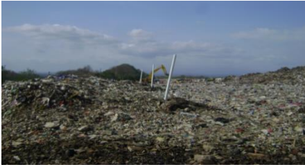
Gambar 6.32. Pemeliharaan dan Pemasangan Pipa Gas Untuk Mencegah Pencemaran Udara dan Penumpukan Gas Methan Di Dasar Timbunan Sampah
