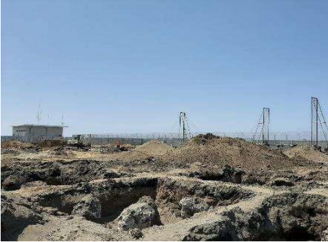
Gambar 6.12. Proses Penggalian Untuk Pekerjaan Pilecap Pada Terminal VIP Bandara YIA
