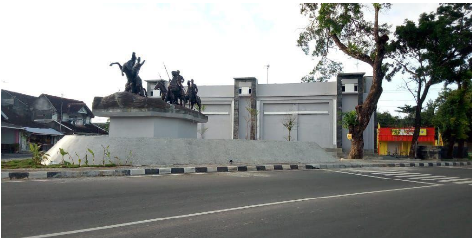
Gambar 5.14. Pembangunan Landmark dan Taman Gapura
