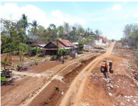
Gambar 6.28. Pekerjaan Land Clearing JJLS Legundi - Planjan
