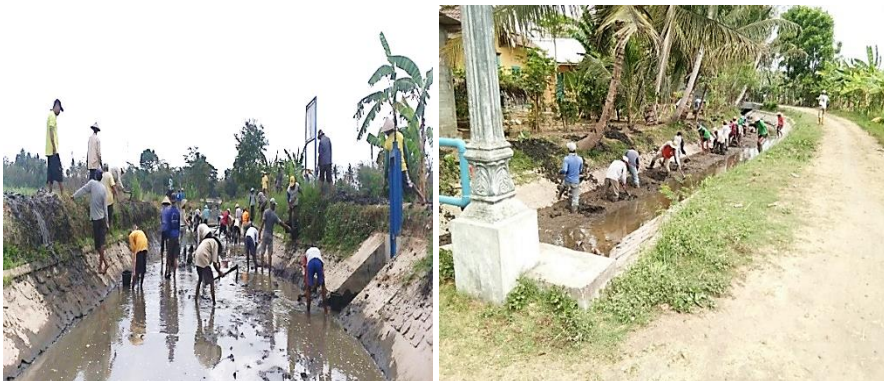
Gambar 4.1. Kegiatan Pemeliharaan Rutin Gali Waled Daerah Irigasi Van Der Wijck
