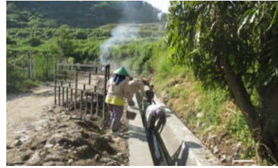
Gambar 6.33. Pemeliharaan Saluran Lindi Yang Berfungsi Melancarkan Aliran Air Lindi Masuk Ke Kolam Treatment Sebelum Dibuang Ke Kali Opak
