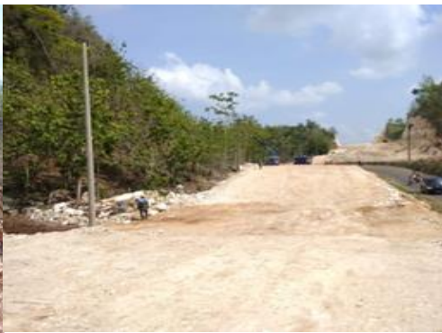
Gambar 6.29. Pekerjaan Pematatan Badan Jalan JJLS Jerukwudel - Duwet
