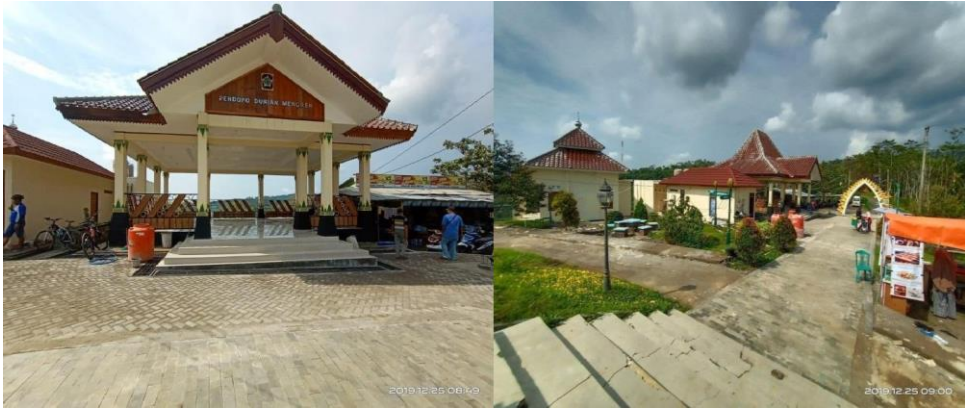
Gambar 5.15. Pemanfaatan Ruang Satuan Ruang Strategis Perbukitan Menoreh (Pembangunan Pendopo dan Gazebo)
