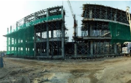
Gambar 6.35. Pembangunan Taman Budaya GK (Auditorium Concert Hall) tampak kanan
