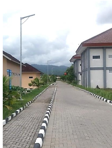
Gambar 6.7. Fasilitas Lampu Penerangan Di Lingkungan JATP
