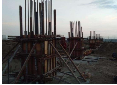
Gambar 6.13. Proses Pengecoran Kolom Pedestal Pada Terminal VIP Bandara YIA
