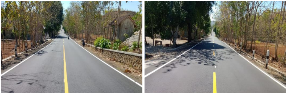
Gambar 4.2. Dokumentasi Pelaksanaan Rehabilitasi Mayor
