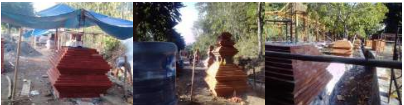
Gambar 2-61 Pekerjaan Pagar Tahun 2023
