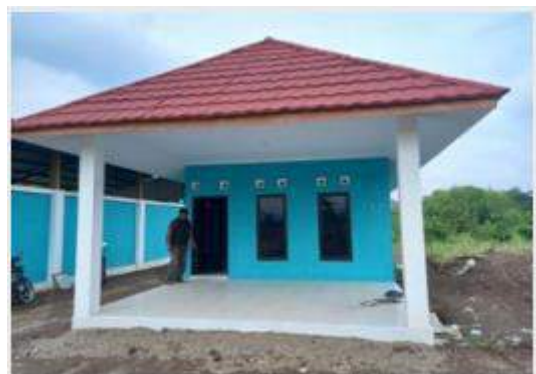
Pembangunan TPS 3R
