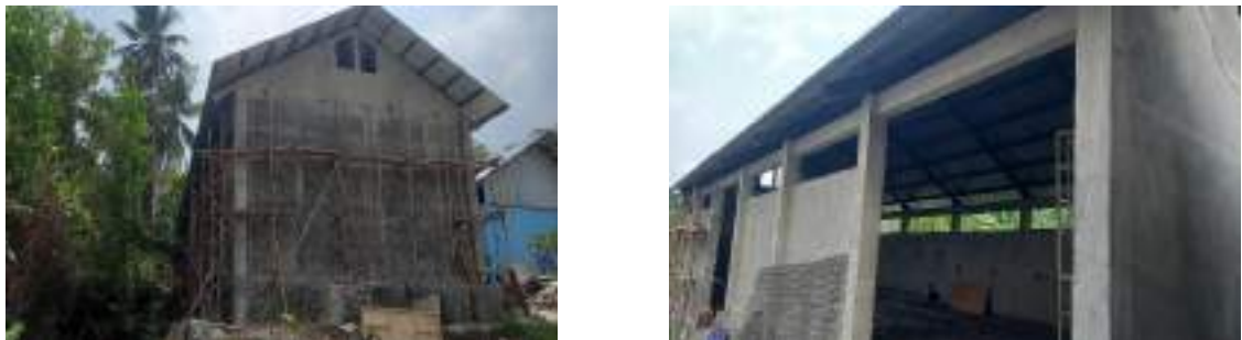
Gambar 2-53 Kegiatan Pembangunan Hanggar Kalurahan Guwosari Tahun 2023
