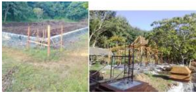
Gambar 2-60 Pekerjaan Pendopo Limasan Multifungsi Tahun 2023
