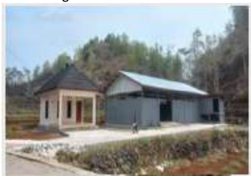
Pembangunan TPS 3R
