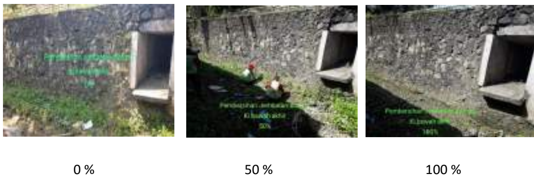
Gambar 3-11 Foto Kegiatan : Pelaksanaan Pekerjaan Jembatan Bolong Tahun 2023
