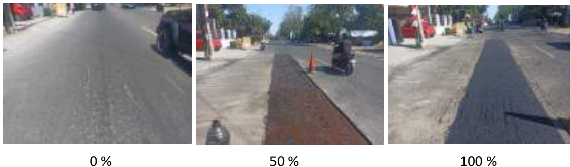
Gambar 3-10 Foto Kegiatan : Pelaksanaan Pekerjaan Ruas Yogyakarta – Bts Kota Bantul Tahun 2023
