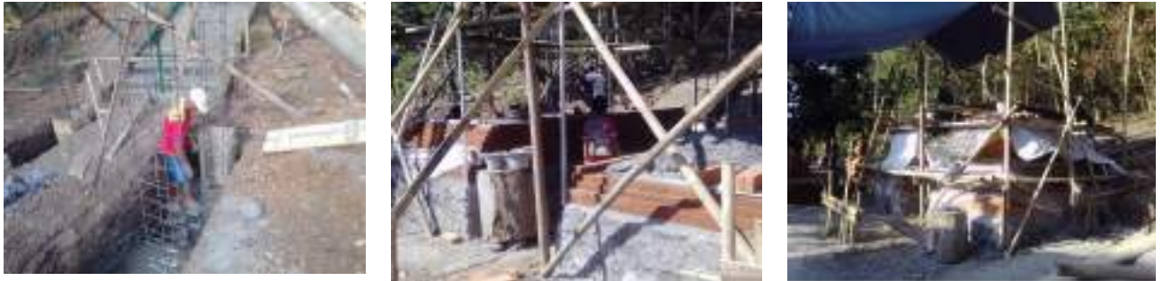
Gambar 2-59 Pekerjaan Gapura Paduraksa Tahun 2023
