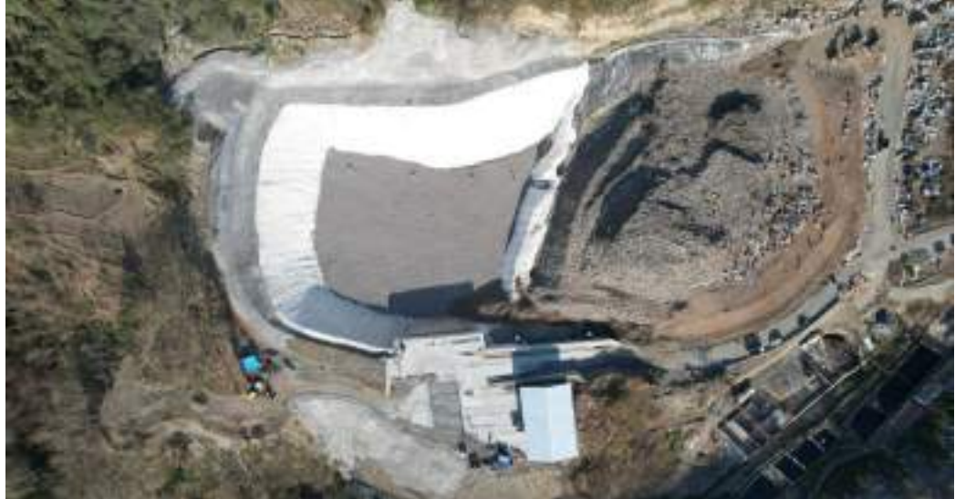
Pembangunan sel landfill TPA Transisi 2
