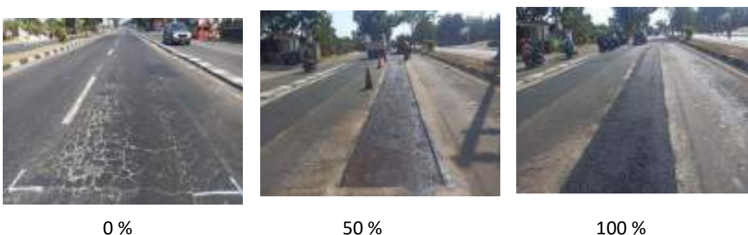
Gambar 3-12 Foto Kegiatan : Pelaksanaan Pekerjaan Ruas Arteri Selatan (Yogyakarta)
