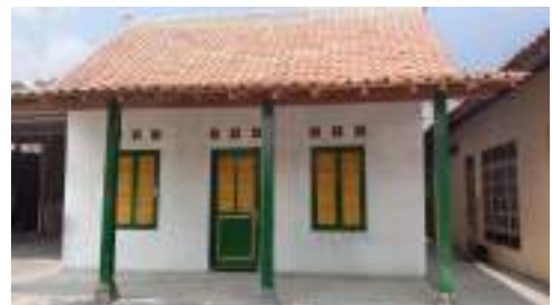
Rehabilitasi RTLH Kabupaten Sleman a.n Nanang Hidayat
