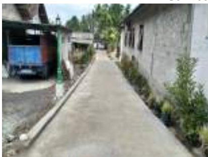
Pembangunan Jalan Cor Sanggar Among Lare
