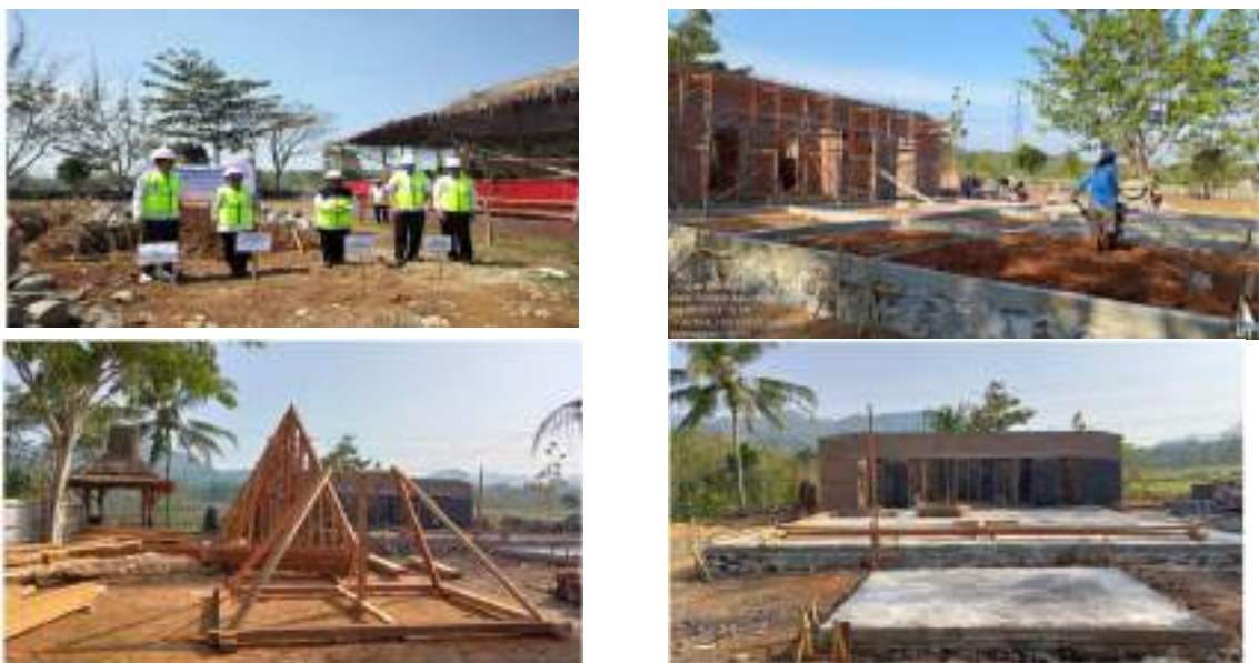
Gambar 2-56 Pembangunan Balai Budaya Kalurahan Ngalang Tahun 2023
