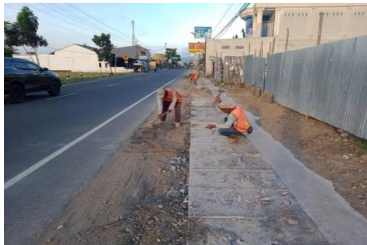
Gambar 4.4. Penanganan Drainase, Trotoar dan Fasilitas Keselamatan Jalan: Jalan Yogyakarta - Piyungan
