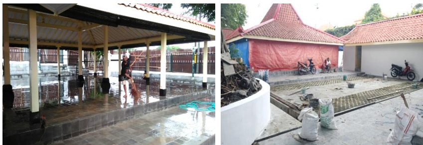
Gambar 3.41. Rehabilitasi WBCB yang dilakukan pada Tahun 2020
