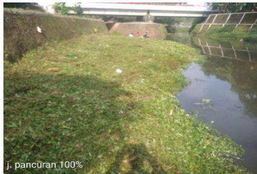
Gambar 4.3. Pemeliharaan Berkala Jembatan: Pembersihan Jembatan Jembatan Pancuran
