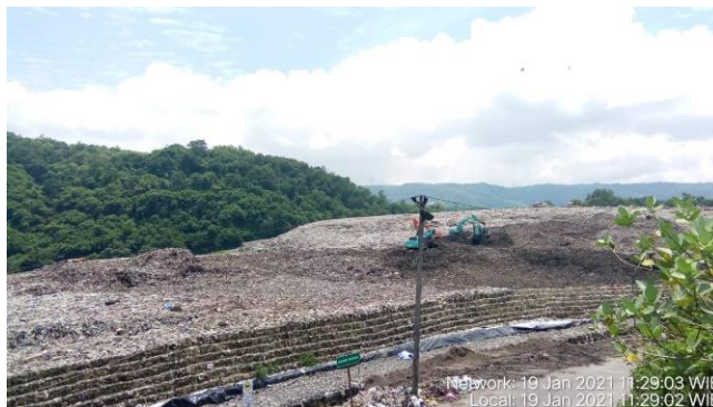
Gambar 6.44. Kondisi Landfill di TPA pada akhir tahun 2020
