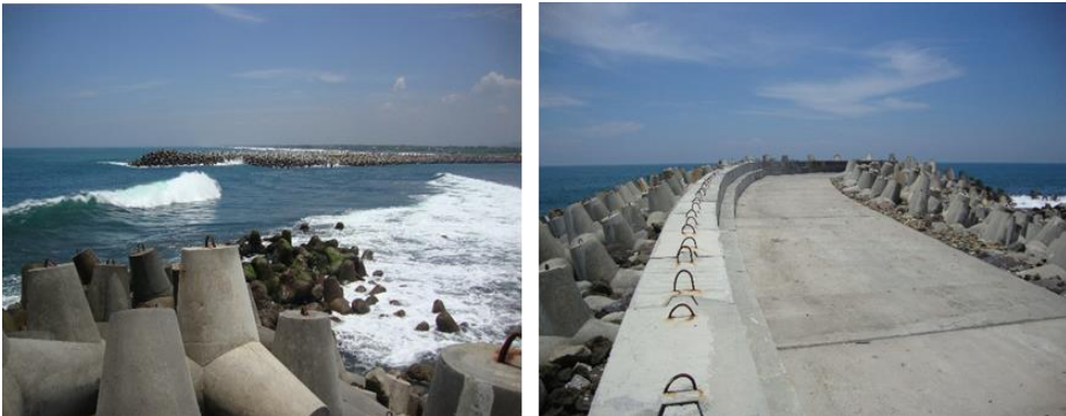
Gambar 6.13. Breakwater Pelabuhan Tanjung Adikarto
