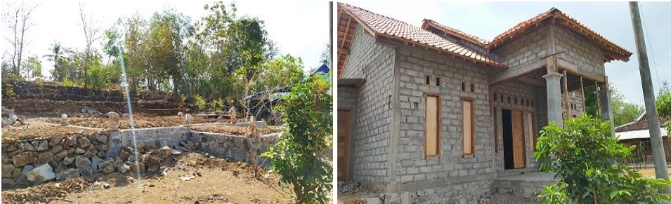
Gambar 3.29. Pembangunan Baru Rumah Layak Huni di Desa Kalitekuk, Semin, Gunungkidul
