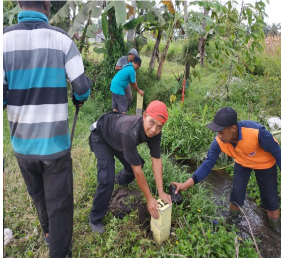
Gambar 5.9. Pemasangan Tegap Batas Desa Sumber: Paniradya Kaistimewan, 2021 (data diolah)
