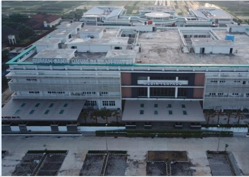
Gambar 6.40. Kondisi Bangunan RSUD Wates Pada Akhir 2020
