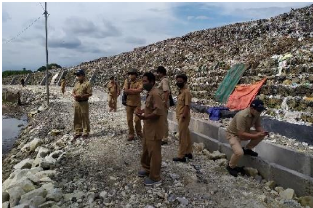
Gambar 3.67. Pengecekan drainase sisi selatan badan sampah
