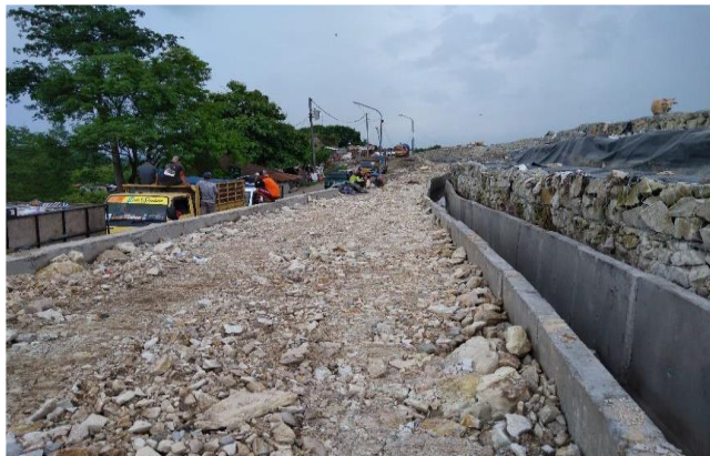
Gambar 3.26. Pelaksanaan Pekerjaan Tanggul Penahan Dinding, Drainase, Saluran Lindi dan Jalan di TPA Piyungan
