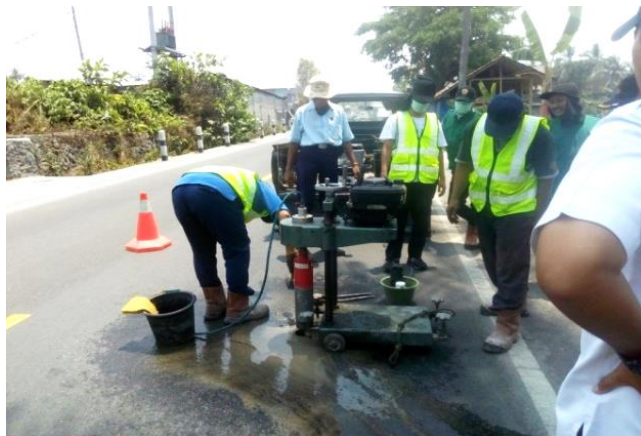
Gambar 3.28. Pengambilan Sampel Core-Drill Aspal Dalam Rangka Pelayanan Laboratorium Pengujian Konstruksi
