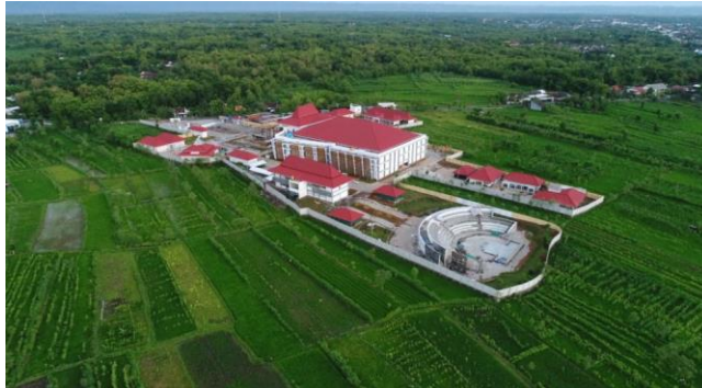
Gambar 6.39. Pembangunan Taman Budaya Gunungkidul
