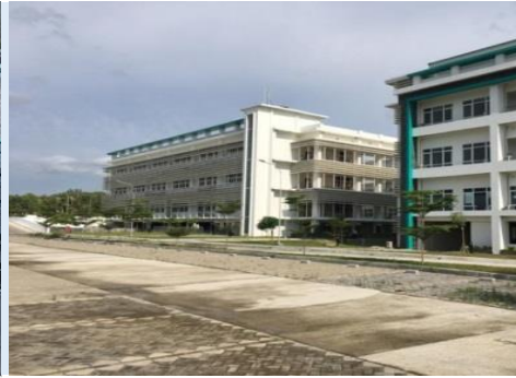
Gambar 6.41. Gedung rawat Inap RSUD Wates
