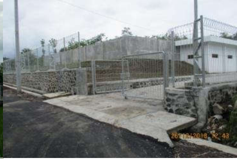
Gambar 6.25. Pembangunan Reservoir Trimulyo
