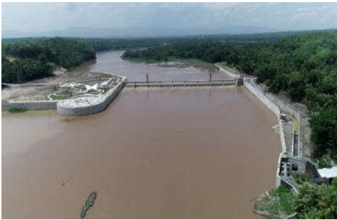
Gambar 6.29. Bendung dan Intake Kamijoro
