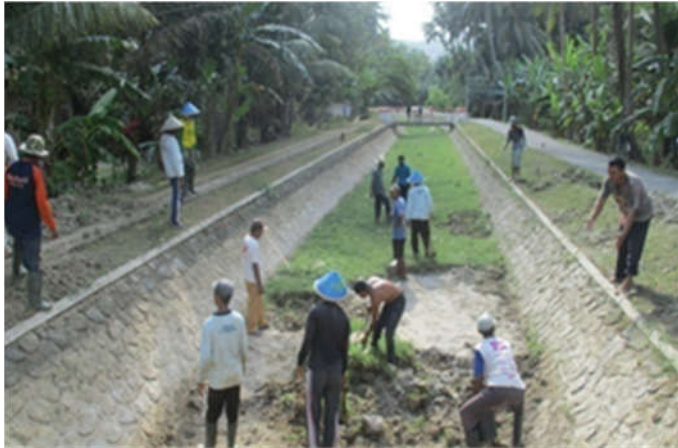
Gambar 7.1. Gali Sedimen pada kegiatan Pemeliharaan Rutin Jaringan Irigasi Kalibawang
