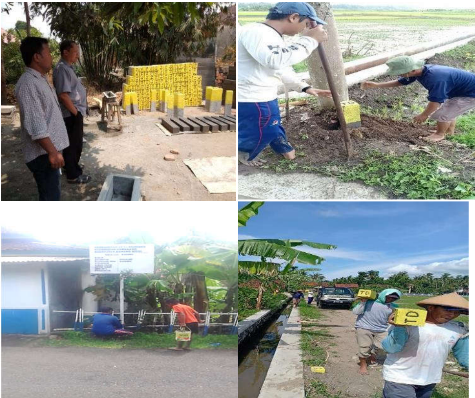
Gambar 5.18. Pembuatan dan Pemasangan Patok dan Papan Nama Tanah Desa
