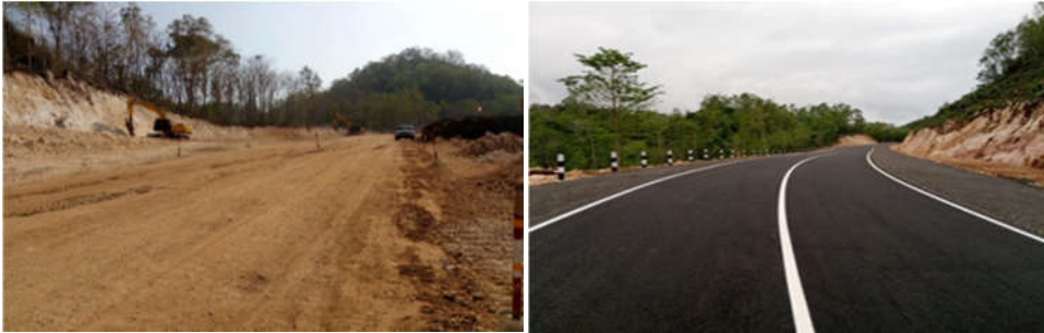
Gambar 6.10. Pekerjaan Land Clearing JJLS Planjan-Tepus
