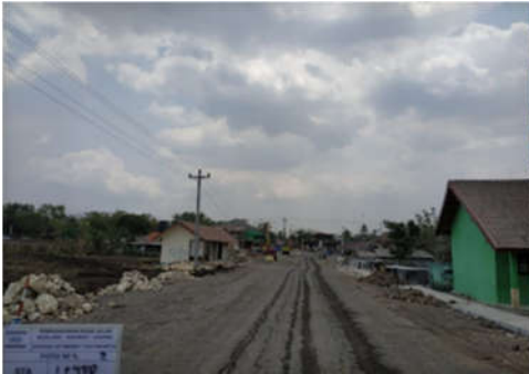
Gambar 6.32. Pembangunan Ruas Jalan Ngalang-Nguwot-Gading
