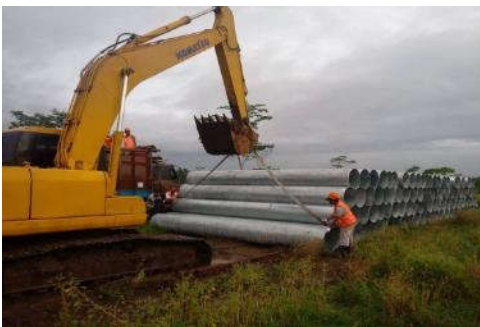
Gambar 6.26. Persiapan Pekerjaan Pemasangan Pipa Transmisi Air Baku
