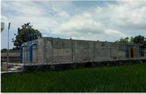
Gambar 6.24. Pembangunan Booster Temon
