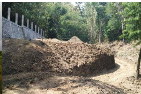
Gambar 6.27. Persiapan Pekerjaan Pembangunan Intake
