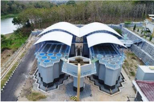
Gambar 6.22. Pembangunan IPA Kapasitas 200 l/det
