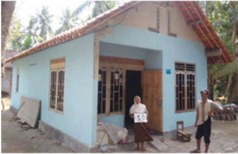
Gambar 6.14. Kondisi rumah tinggal setelah penanganan RTLH di Desa Karangsewu, Kab. Kulon Progo Sumber: Sebermas DIY, 2019
