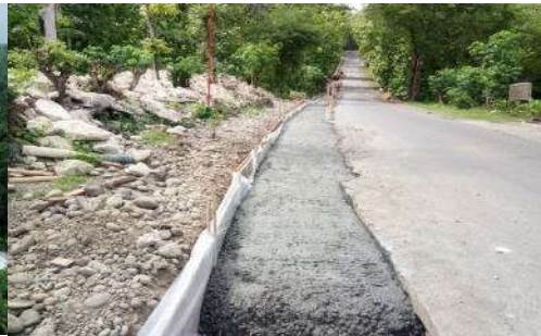
Gambar 6.30. Pekerjaan Pipa Transmisi SPAM Regional Kamijoro I
