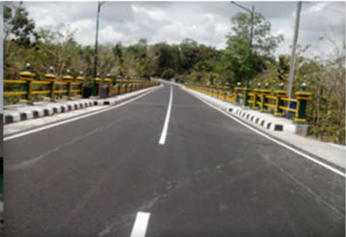
Gambar 6.33. Pembangunan Ruas Jalan Ngalang-Nguwot-Gading (Jembatan Plasari/Jembatan Nguwot)
