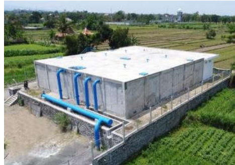
Gambar 6.23. Pekerjaan Reservoir Interkoneksi
